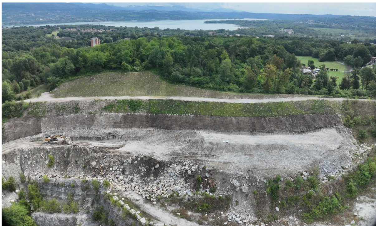
Fig. 5.1: Fronte orientale porzione settentrionale: operazioni di profilatura dell'area interessata dalla frana del novembre del 2021
